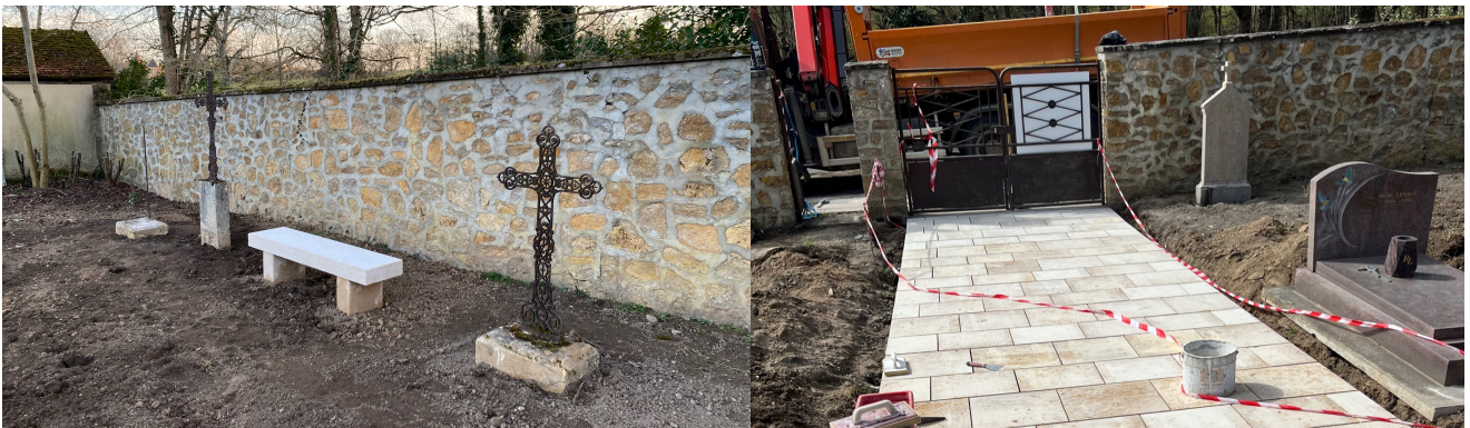
Mise en place de bancs, d'anciens monuments funéraires et de dallage
