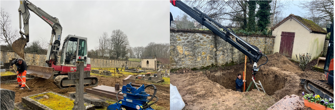
Travaux sur les tombes abandonnées et création d'un ossuaire
