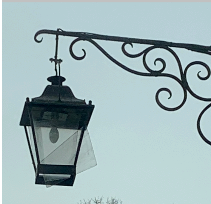
La corrosion due à la rouille et la fin de production du type d'ampoule utilisée obligent à prévoir leur remplacement
